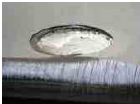
1. Пробива се отвор в конструкцията с диаметър Ø 300 мм, грундира се настилката, полага се първия слой битумна мембрана
