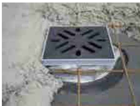
8. Залива се с бетон
