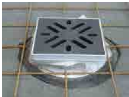
7. Удължителният елемент се обвива с геотекстил и се полага метална армировъчна мрежа
