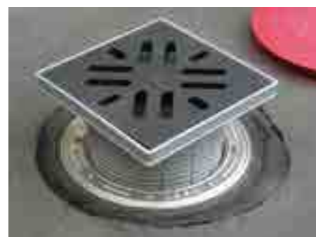
6. Предпазният капак се сваля, удължителния елемент се коригира чрез скъсяване за нагаждането му към вече установеното ниво на настилката
