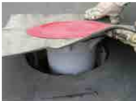
2. Полага се подовия сифон HL616H, с поставен вече предпазен капак
