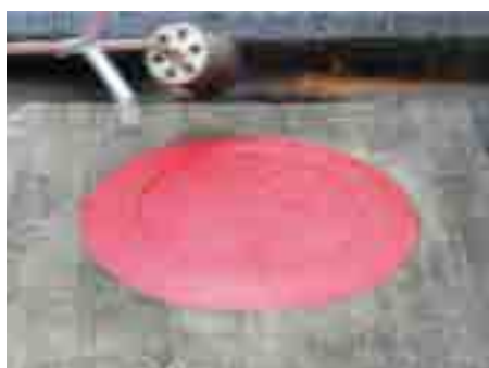
4. Втория битумен слой се свързва с битумния маншет на подовия сифон
