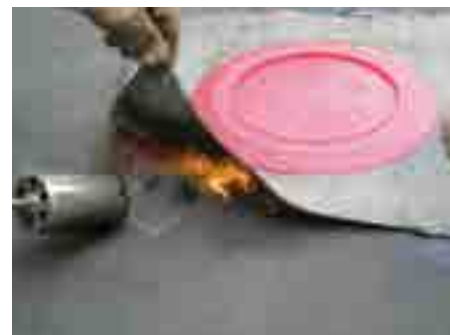
3. Битумният маншет на подовия сифон се заварява газопламъчно върху първия слой битумна мембрана
